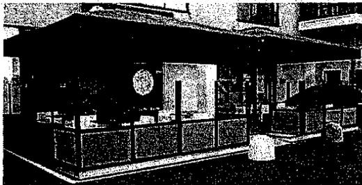
Esempio di barriera con l'inserimento di un pannello di vetro opaco per un'altezza di 1 mt da terra
